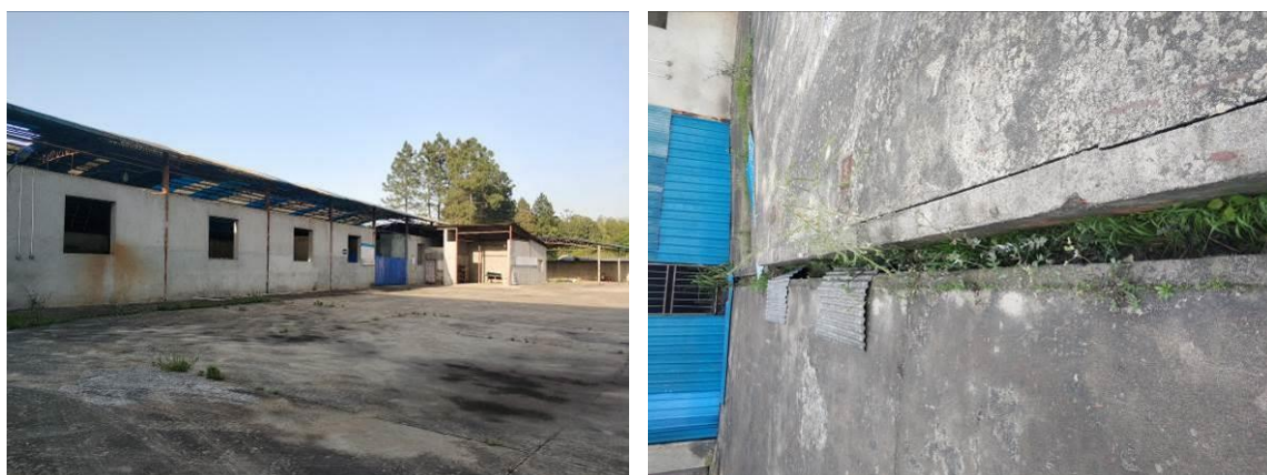
图 2.2-12 场区内硬化地坪与雨水导排沟
