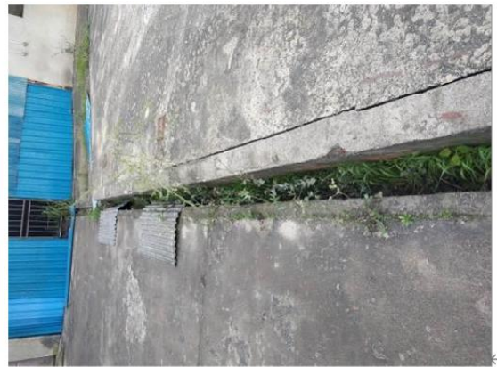
图 2.2.3-7 场区内硬化地坪与雨水导排沟
