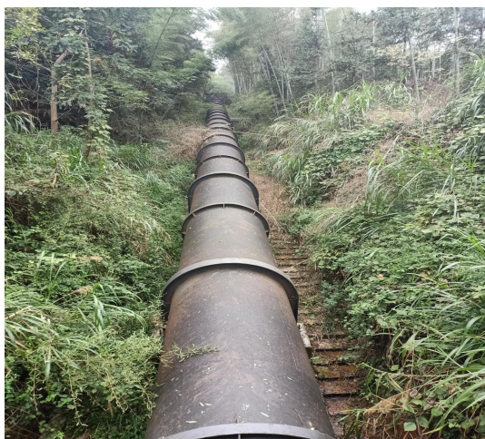
图 3.2-31 电站引水管道
