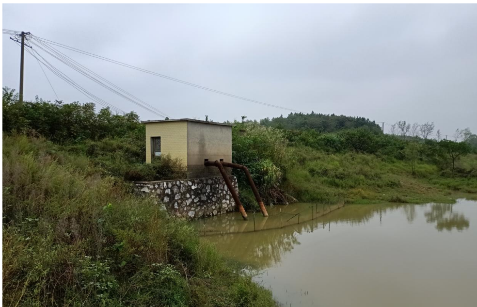
图 3.2-33 泵站泵房和进水口
