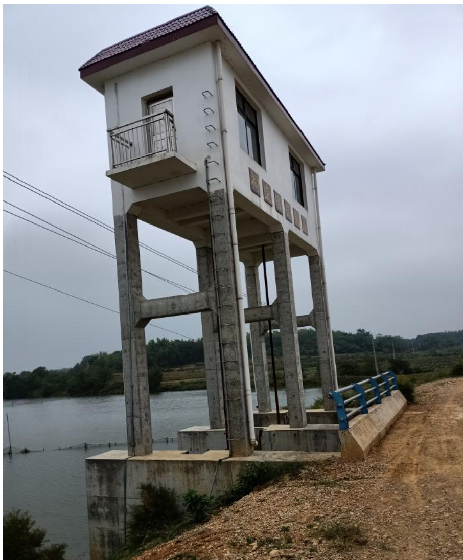
图 3.2-29 上游连接段、闸室段
