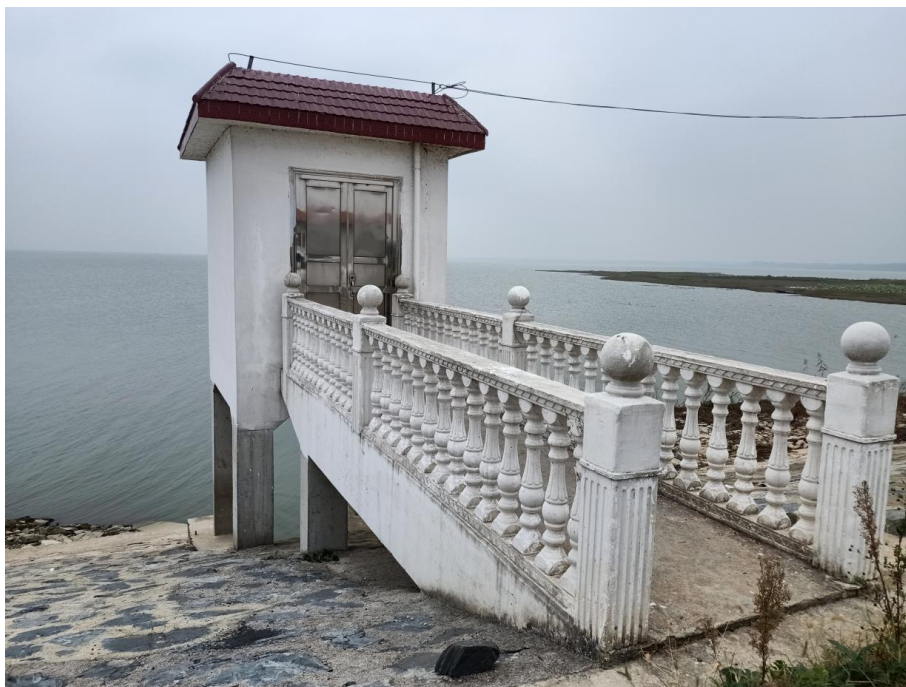
图 3.2-33 泵站启闭机房和进水口
